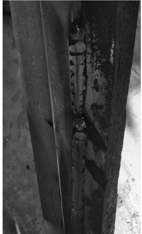
Dettaglio della saldatura appena eseguita
