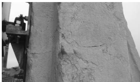
Dettaglio dell'incollaggio della colonna esterna verso nord
