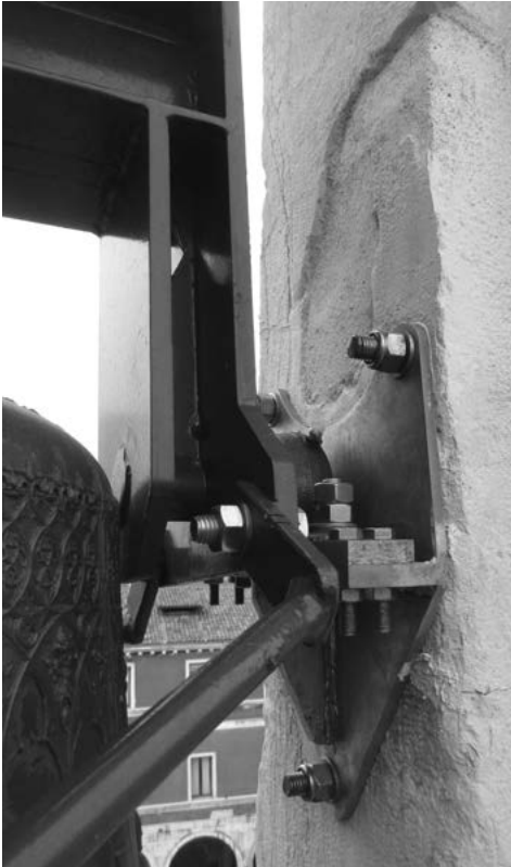
Particolare di una staffa laterale di supporto delle campane
