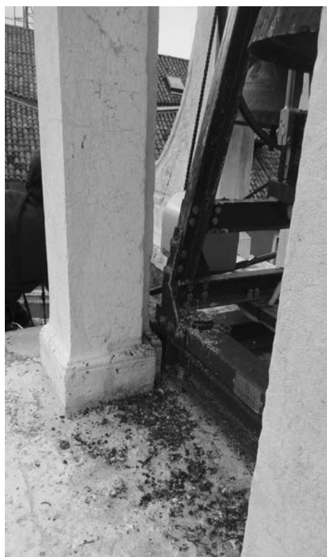
Elevata presenza di guano sulla lastra di base e sul castello di sostegno della campana maggiore
